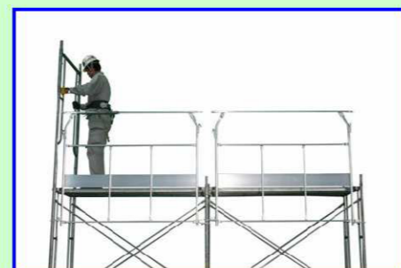
⑦2層目の建わくを組立てる
