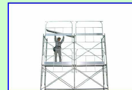
⑫2層目建わくに踏板を取付ける
