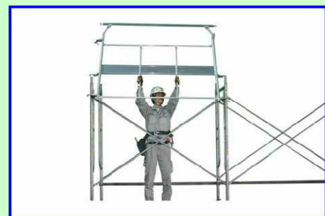
①1層目の建わく横架材に先行手すり枠のフックを預ける
