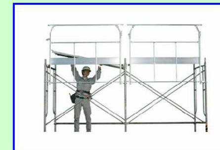
④1層目建わくに踏板を取付ける
