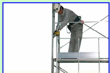
⑨押さえ金具を建わく支柱に差込み固定する
