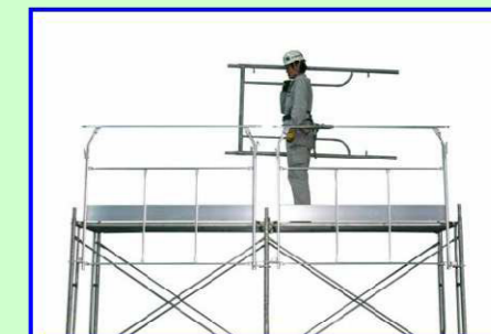
⑤2層目の建わくを組立位置まで担いで横移動する
