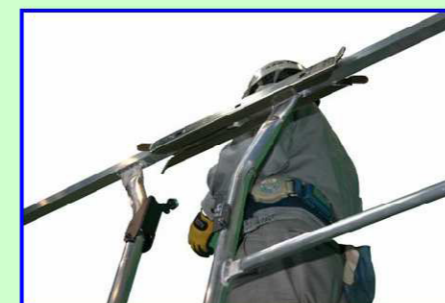
⑥上棧にパスオーバー(安全帯取付器具)を取付けて横移動する
