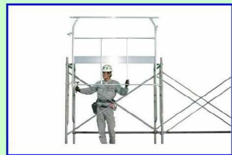
②固定金具を建わく支柱に差込みクサビを打込んで固定する
