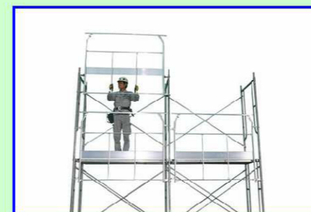
⑪2層目の建わく横架材に先行手すり枠のフックを預ける
