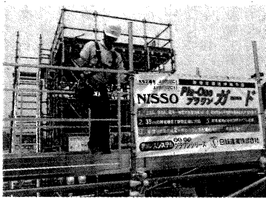
デモ施工の様子
